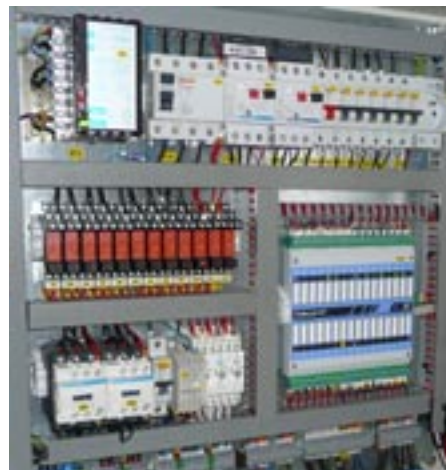
Rozvaděč řízený jednotkou DataLab
